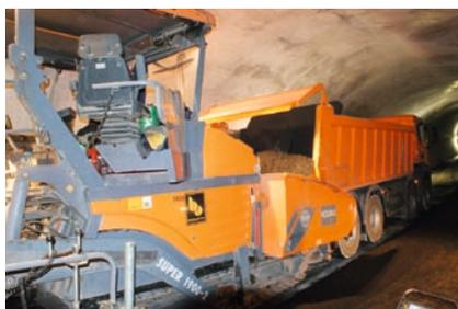
Asphalтарbeiten untertage mit dem ASW Stone Lkw-Asphalt
