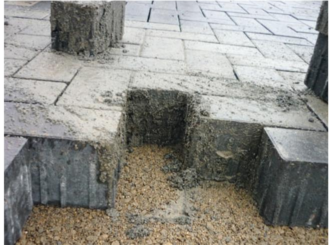
Homogen gefüllte Fuge mit verschlammter Bettungsfläche
